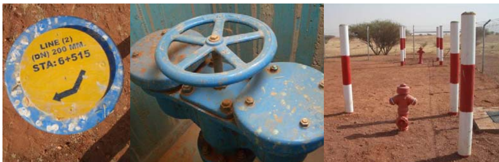
Poste indicador (der.), válvula ventosa (cen.), hidrantes (der.)
